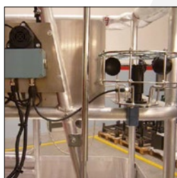
Windgeschwindigkeitsregelvorrichtung mit Alarm.
